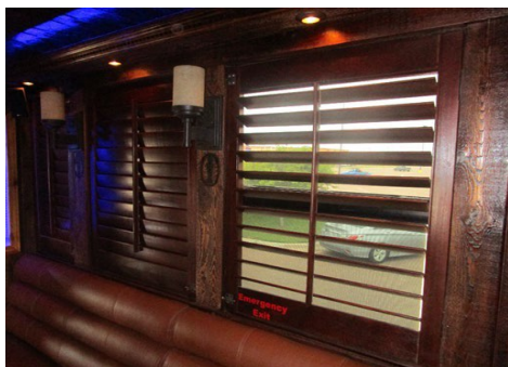
Sortie obstruée par des volets en bois.
