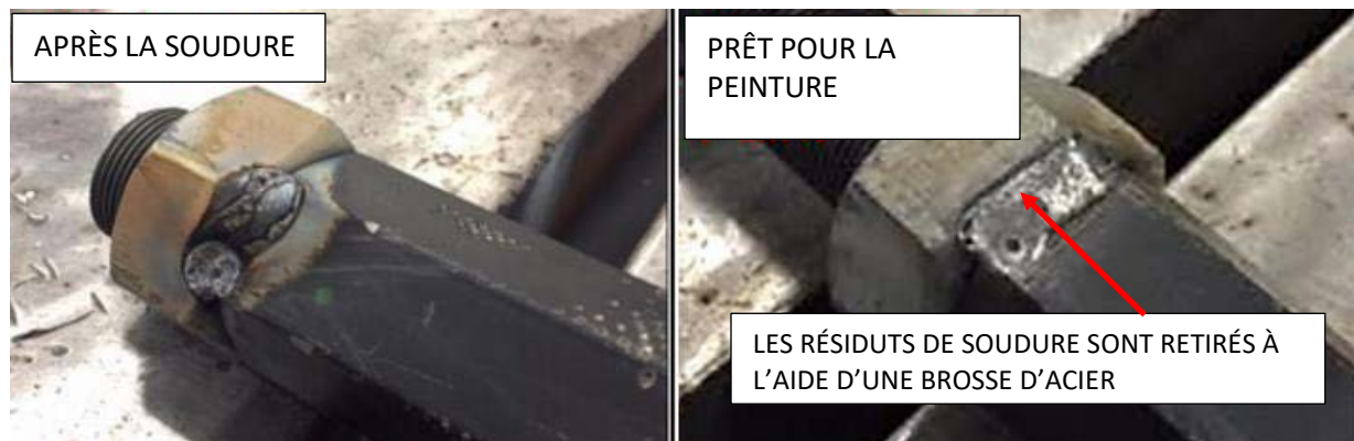
Figure 3: Assemblage de barre d'accouplement réparé selon le rappel de sécurité
